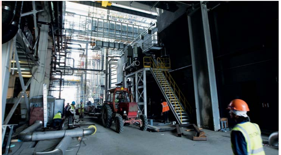
Монтаж оборудования энергоблока ПГУ 410 МВт Среднеуральской ГРЭС
